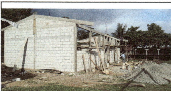
Foto 6: Vista que ya ha llegado la estructura, faltaria la colocacion de techo costaneras.
