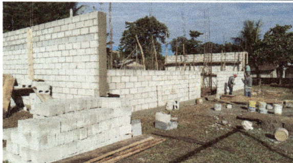
Foto 2: En proceso de remozamiento
